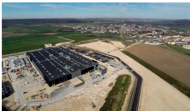
Commercy : vue aérienne du site en travaux.
