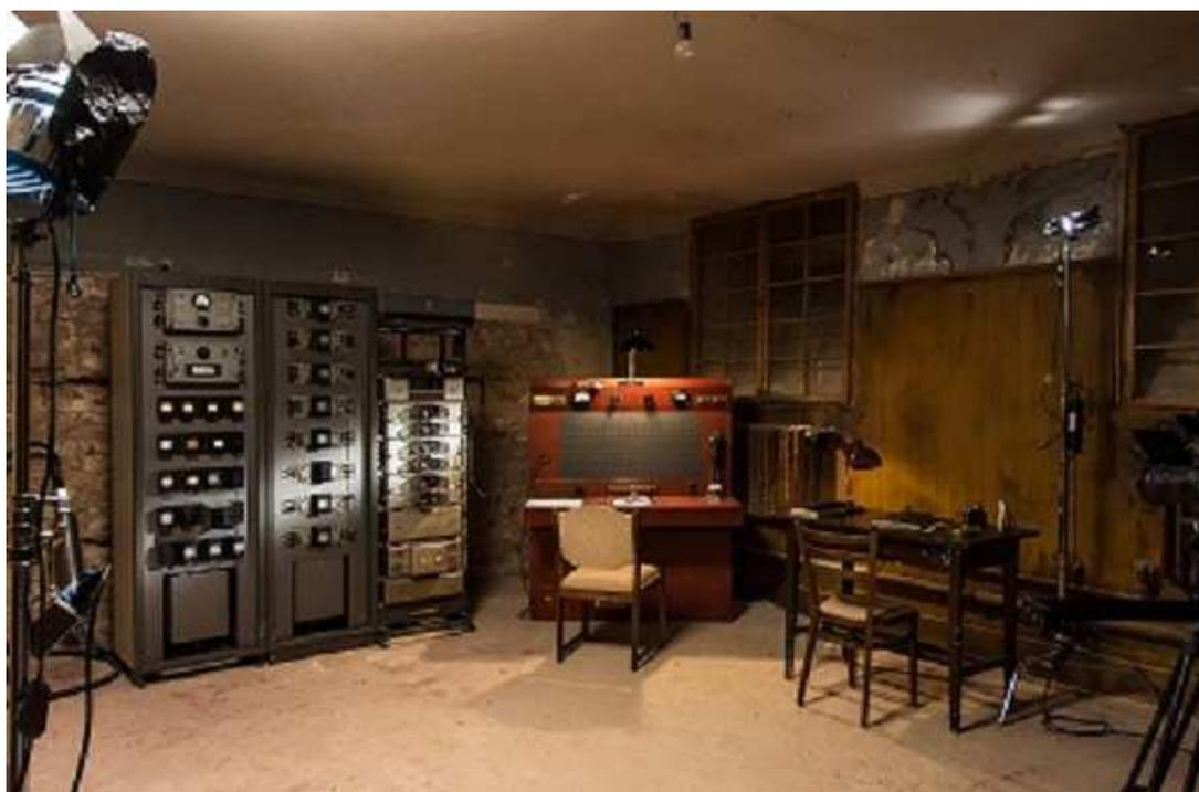
Décor technique prêt pour le tournage (à gauche de la photo les 3 baies techniques : baies de gauche et du centre : têtes de câbles, de droite : baie d'amplification, au centre de la photo : table d'écoute ; à droite de la photo : bureau d'exploitation des PV d'écoute)
