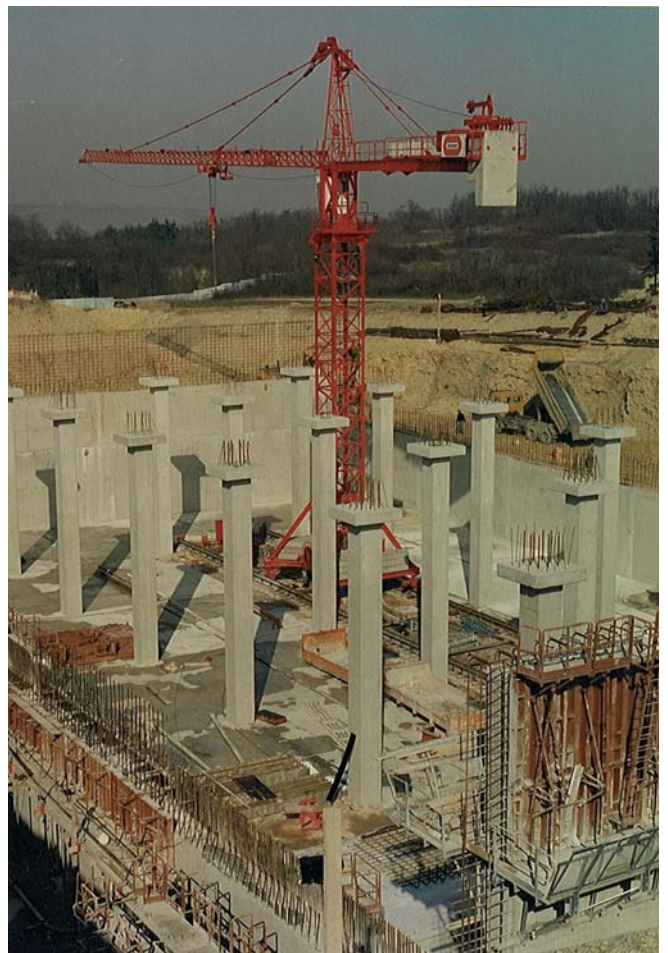
Construction du centre de guerre électronique
